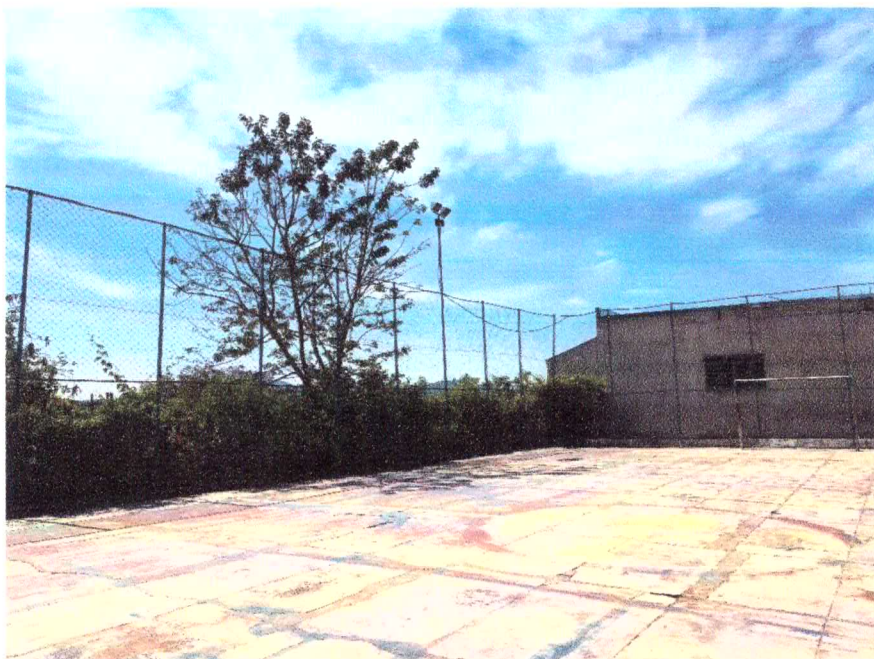
Figura 5 - Piso da Quadra
