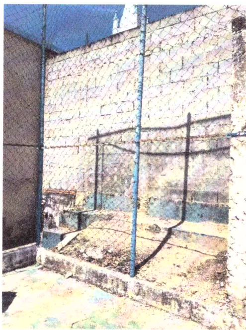
Figura 14 - Arquibancada a ser Demolida
