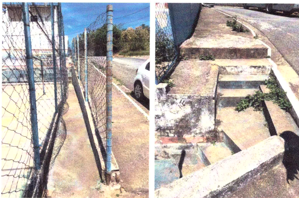
Figura 15 - Entrada da Arquibancada
